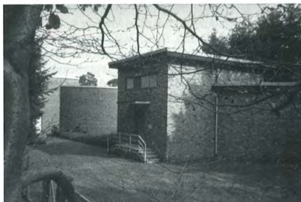
Gruppenwasserversorgung „Eichelberg“: Haupthochbehälter.
