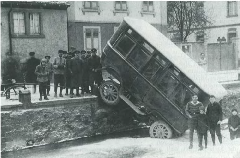
Winter 1928/29. Vereiste Straße in Großsachsen, der Anhängen des Arbeiterbusses stürzte in den Apfelbach.
