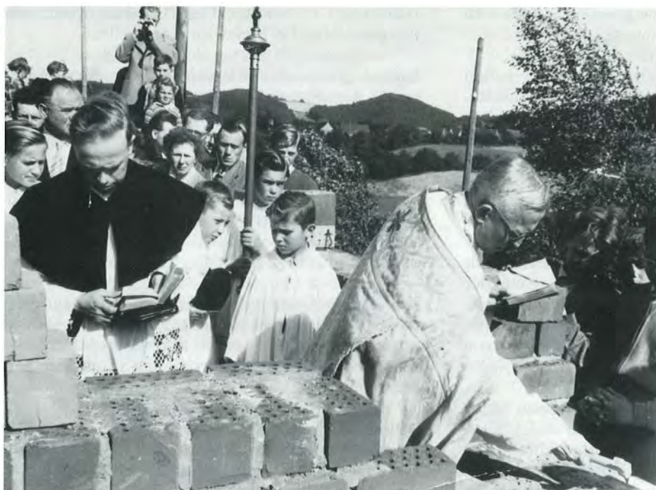
Grundsteinlegung zur Herz-Jesu-Kirche in Oberflockenbach durch den Geistlichen Rat Dr. Alfons Beil am 26. August 1956
