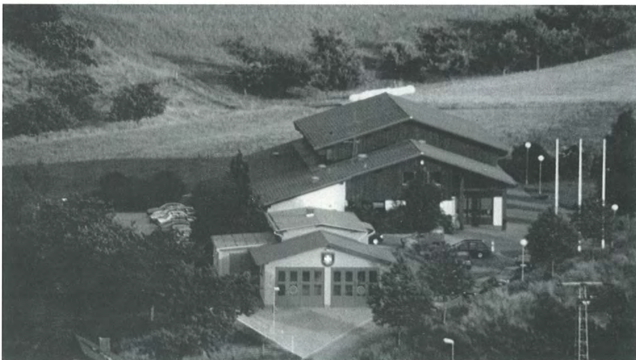
Die Keltensteinhalle mit dem Feuerwehrhaus im Vordergrund.
